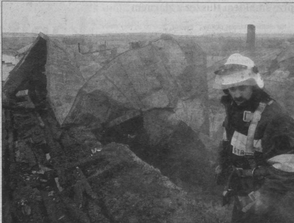
Widok na spalone, zawalone dachy.
